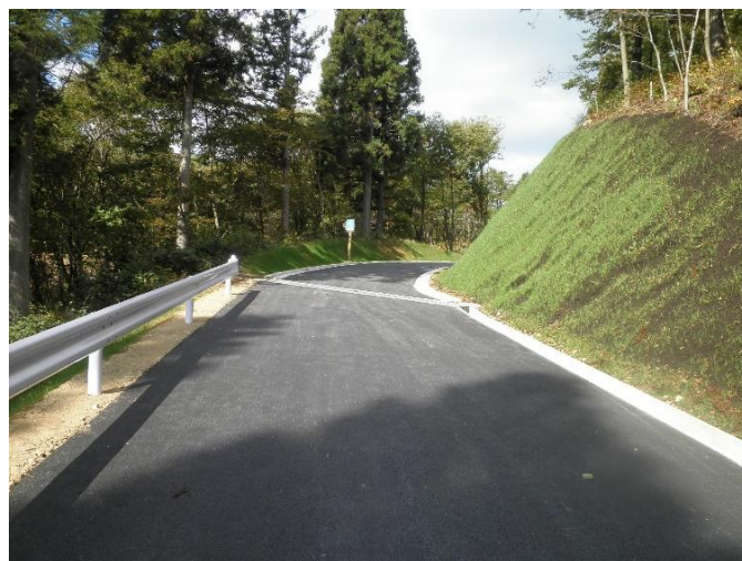
令和6年3月に整備が完了した林道登米東和線
