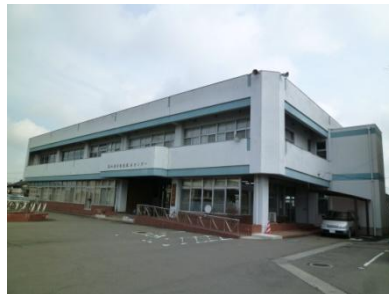
米山農村環境改善センター (米山公民館)
