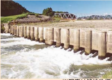
※写真は鵜波洗堰
