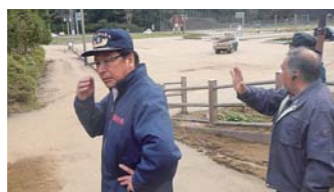
現地で被災状況を確認する栗原市長
