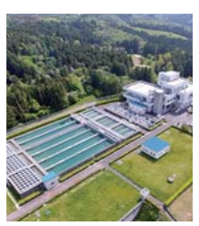
保呂羽浄水場
