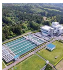
保呂羽浄水場
