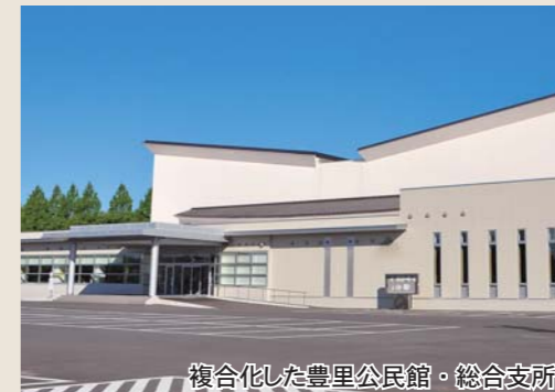
複合化した豊里公民館・総合支所
