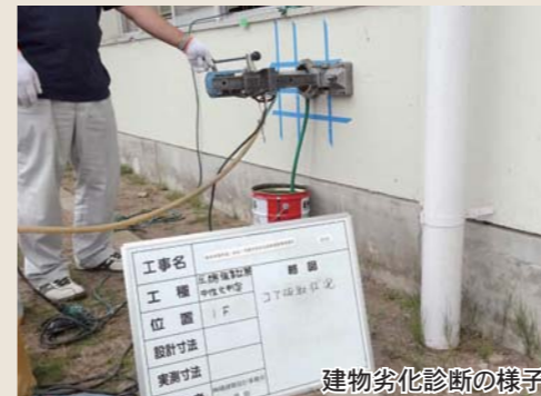
建物劣化診断の様子
