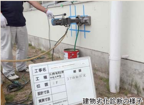
建物劣化診断の様子
