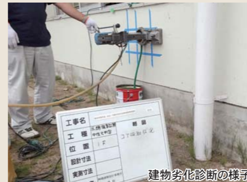
建物劣化診断の様子
