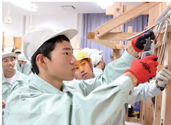
講習会では、配線から照明器具の設置まで実施。住宅の電気工事を想定し、図面を見ながら慎重に配線していました。
