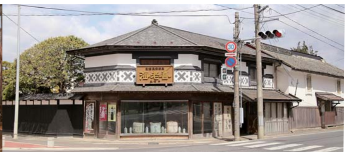
旧店舗：スレートで葺いた屋根と2階のなまこ壁が特徴
