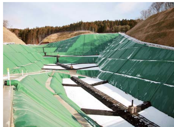
処分場には、埋め立て灰などに浸透した雨水などを無害化する処理施設が併設され、環境の保全に万全を期しています。
