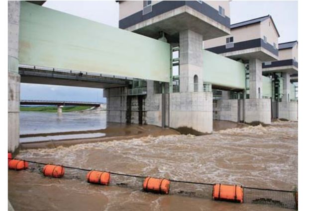
11日午後3時頃には、越流堤を越えた水が轟音を響かせながら長沼に流れました。
