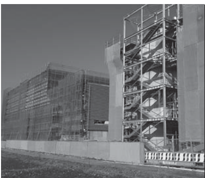
▼▲新校舎の建築工事は計画通り順調に進んでいます。完成予定は本年3月13日です
