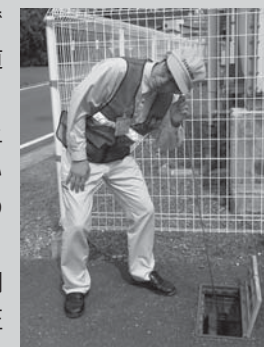
▲音聴棒という器具で振動音を聞き、漏水の有無を確認します
