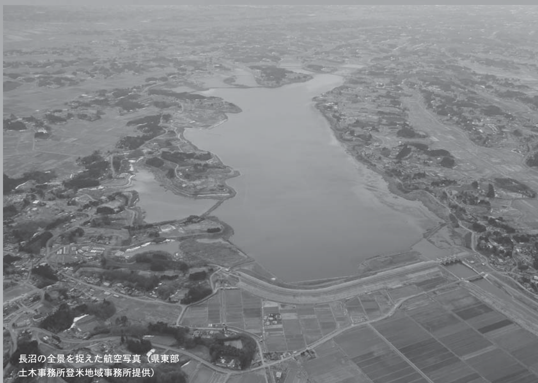
▲試験湛水で最高水位まで水をためた後、今度は最低水位まで下げるため、水門から迫川と荒川にダムの水が放流されました（2月25日）
