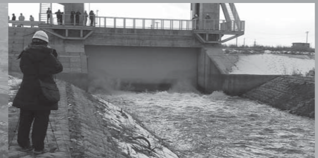
▲試験湛水で最高水位まで水をためた後、今度は最低水位まで下げるため、水門から迫川と荒川にダムの水が放流されました（2月25日）
