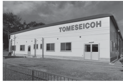
本社工場敷地内に完成した登米精巧の新工場。地元企業として、自動車産業への参入を果たしました
