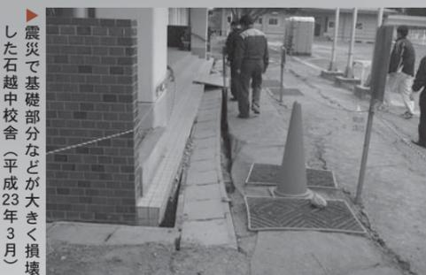
▶震災で基礎部分などが大きく損壊した石越中学校舎（平成23年3月）
