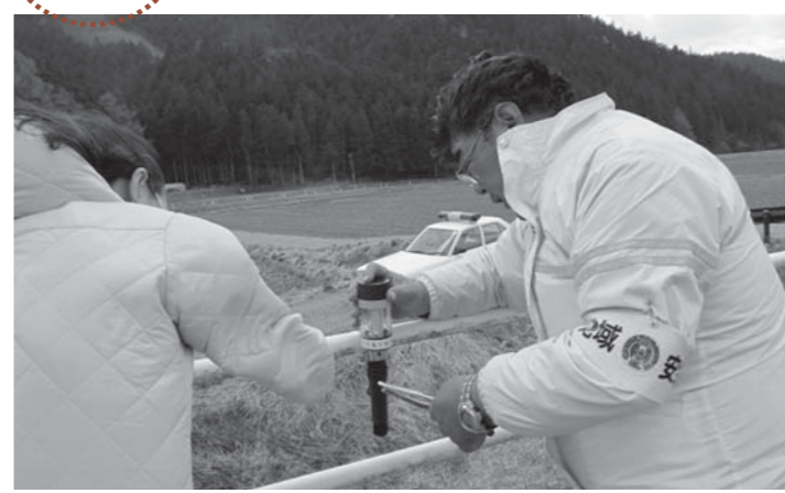
▲登米警察署などの協力のもと、ガードパイプヘライトを設置する隊員たち
