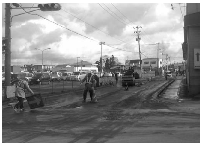
市内各所で順次復旧作業が行われている「道路災害箇所」
