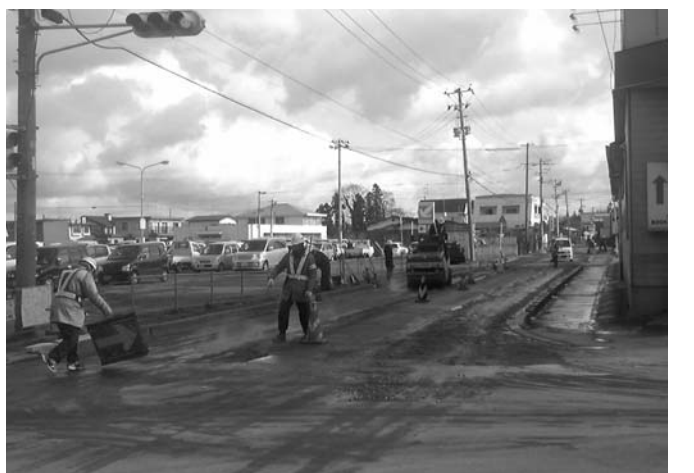
市内各所で順次復旧作業が行われている「道路災害箇所」
