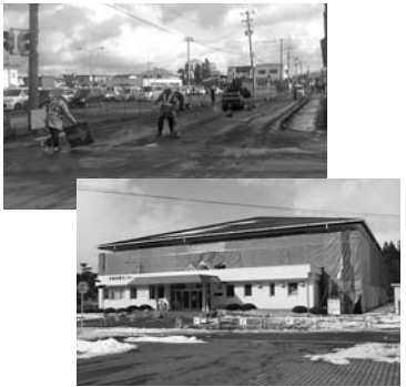
本格復旧が進む市道（上）と復旧工事中の石越体育センター（下）
