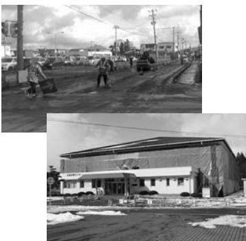
本格復旧が進む市道（上）と復旧工事中の石越体育センター（下）
