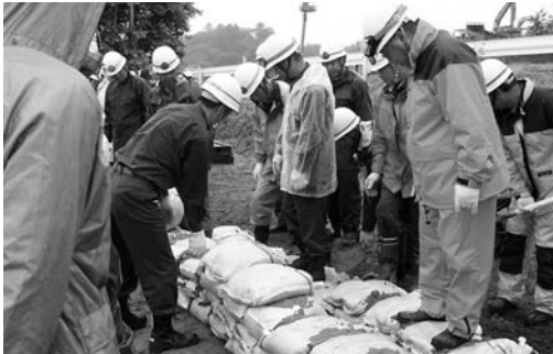
堤防からの越流を防ぐ積み土のう工法
