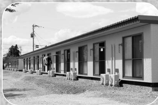
▲イオン南方跡地に建設された仮設住宅
