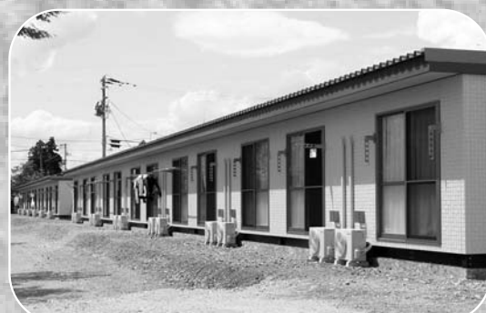
▲イオン南方跡地に建設された仮設住宅
