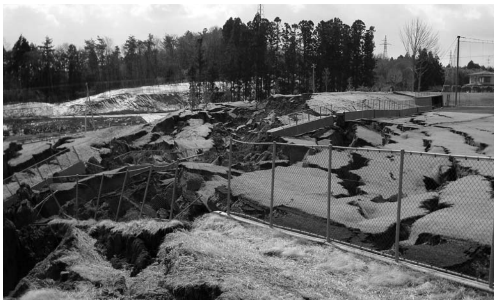
【地震によって大きく地面が裂け崩壊した東和総合運動公園の野球場】
