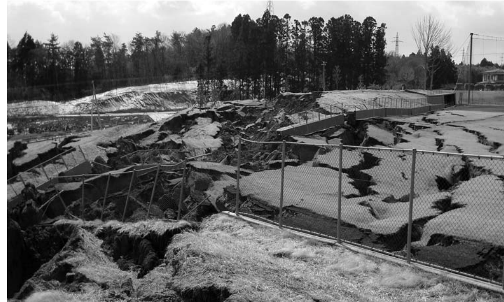
【地震によって大きく地面が裂け崩壊した東和総合運動公園の野球場】
