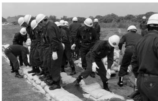
堤防からの越流を防ぐ積み土のう工法（南方支団）
