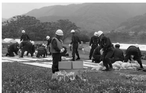
流水による掘れを防ぐシート張り工法（豊里支団）
