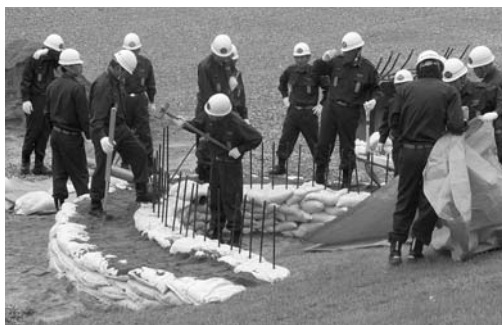
水の力を弱め堤防決壊を防ぐ月の輪工法（米山支団）
