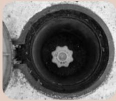
凍結防止用ヒーターのコンセントは確実に差し込み、寝る前や家を長期に留守にする場合は、水抜栓を使い水道管内の水を抜きましょう。
