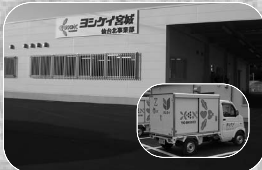
▲完成したヨシケイ宮城「仙北事業部」と宅配車両
