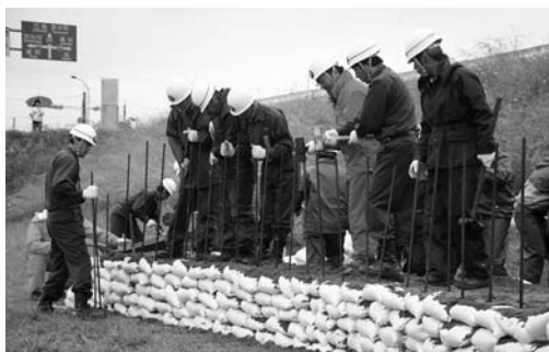
土のうと鉄杭で塀を作る積み土のう工法【石越支団】
