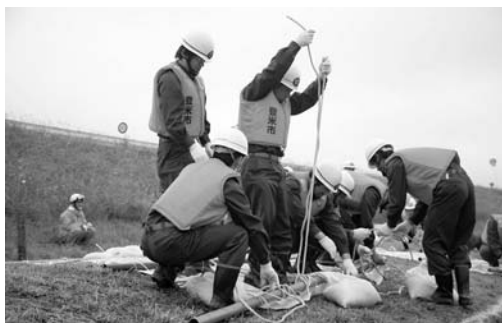
堤防を水流から守るシート張り工法【中田支団】
