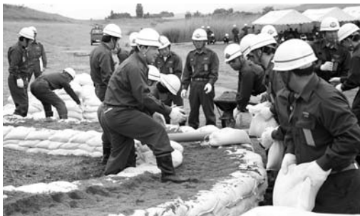
堤防からの漏水の勢いを抑える月の輪工法【迫支団】
