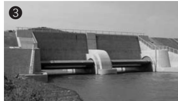
③端部の円盤を回転させ水門ゲートを動かす「鴉波水門」
