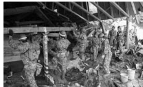
◀駒の湯温泉倒壊現場での作業の様子
