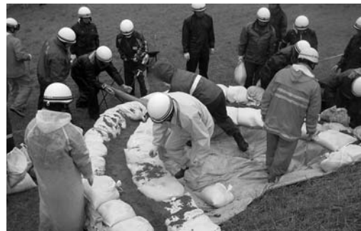
素早い作業で月の輪工法を完成させる登米支団員
