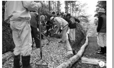
3 車がすれ違うことができない華足寺北側山道の待避所整備 2 乗合タクシー出発式の模様 3 若草山公園の散策道にスギのチップ材を敷きならす米川小児童ら
