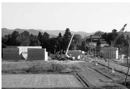
下部工工事の進む日野渡橋
