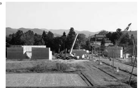
下部工工事の進む日野渡橋
