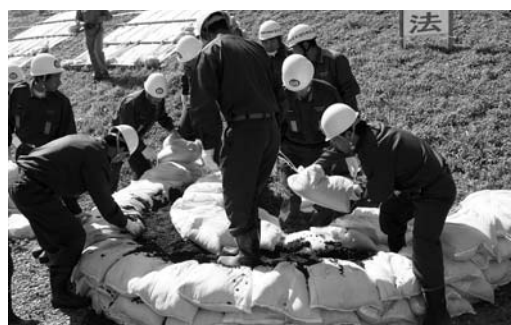
豊里支団員による月の輪工法
