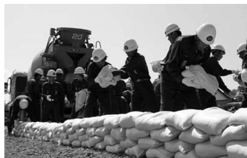
米山支団員が力を合わせて土のうを積み上げました
