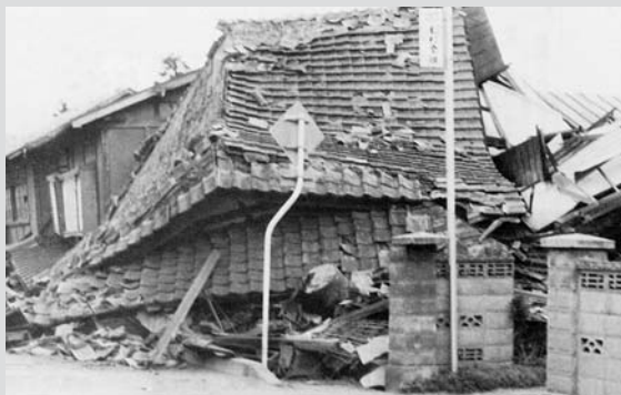
昭和53年6月に発生した宮城県沖地震で倒壊した家屋
