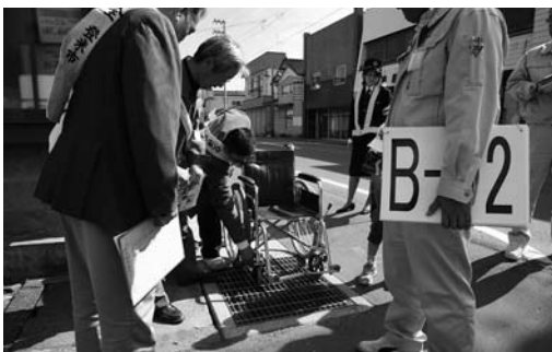
車いすの車輪が歩道の側溝に落ちることが判明
