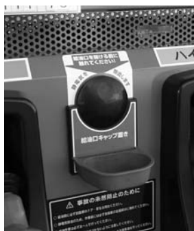
◀中央の黒い部分が静電気除去装置
