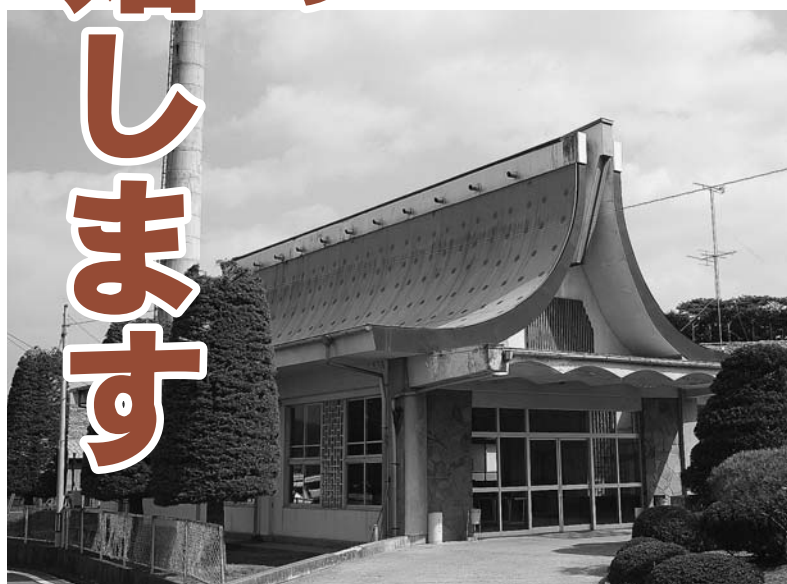
手狭なうえ、老朽化が進んでいる現在の火葬場（昭和47年建築）
