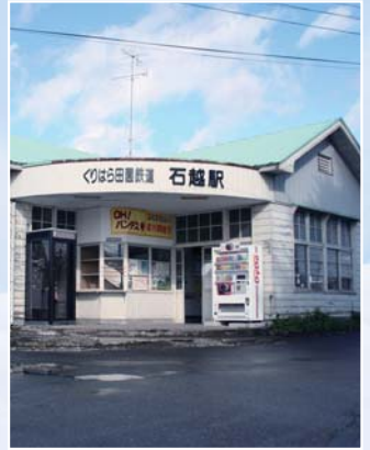
昭和初期に建設された石越駅。木造づくりで味わい深い駅舎となっています
