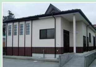
登米市後小路町内会で整備した 集会施設
