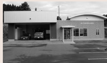
◀石越総合支所敷地内に移転新築した北出張所
